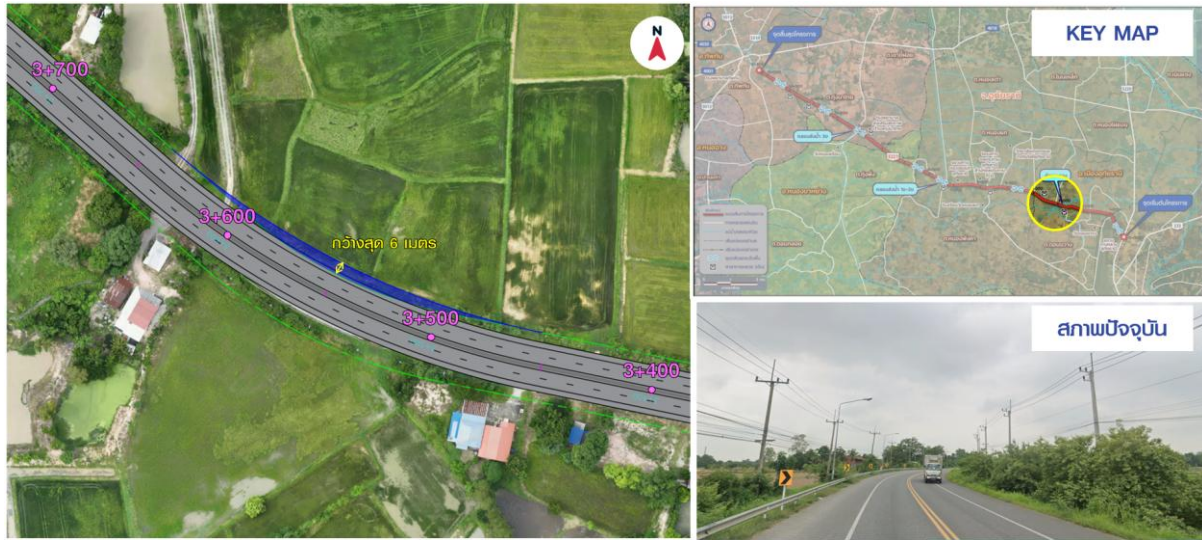
รูปที่ 6-10 ปรับปรุงแนวทางราบ กม.3+550
