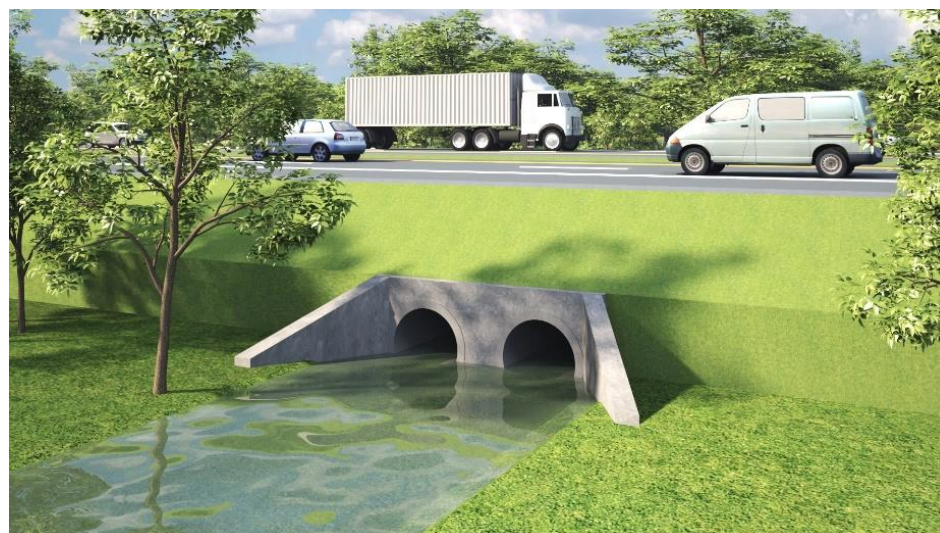
รูปที่ 6-22 ท่อระบายน้ำชนิดกลม จำนวน 2 แถว
