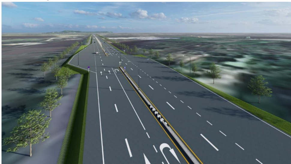
รูปที่ 6-17 ทศนิยมภาพจุดกลับรถรองรับรถบรรทุกขนาด 6 ล้อ
